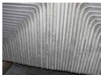
B) Widok komory spalania kotła rusztowego i popiołu z pelletów z biomasy agro z dodatkiem haloizytu – na ścianach komory brak jest szlaki, popiół jest sypki, brak spieków
