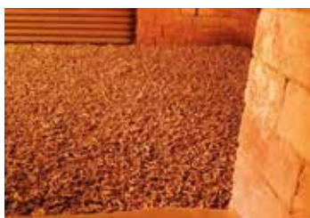
C) Widok komory spalania kotła fluidalnego po 112 dniach spalania biomasy agro z dodatkiem haloizytu – dodatek był podawany wraz z paliwem
