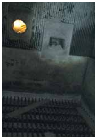
C) Widok komory spalania kotła fluidalnego po 112 dniach spalania biomasy agro z dodatkiem haloizytu – dodatek był podawany wraz z paliwem
