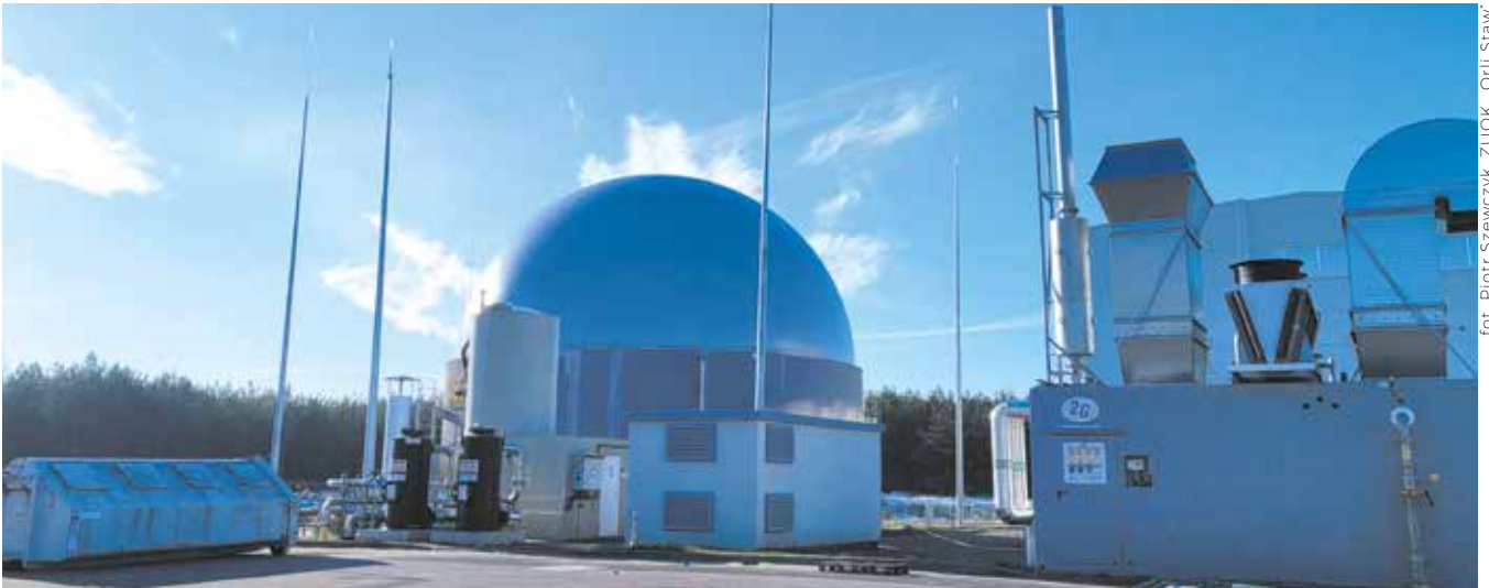
ZUOK „Orli Staw” – zbiornik pofermentu i biogazu, agregat kogeneracyjny
